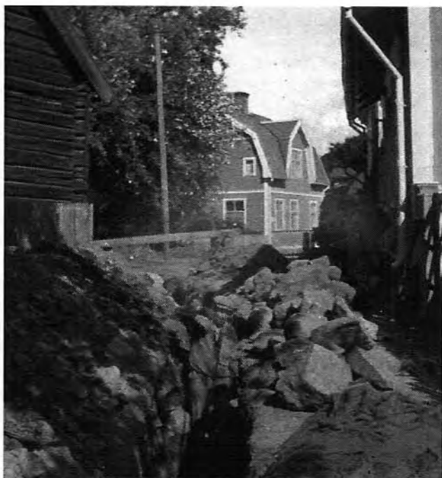
Schakt i Stora Nygatan vid vattenledningsgrävningen 1925. Kv. S:ta Gertrud t.v. och kv. Urmakaren t.h. Stenarna på den högra schaktkanten härrör från grunden till kyrkolämningen i museets trädgård. Foto i Sigtuna Museums arkiv.
