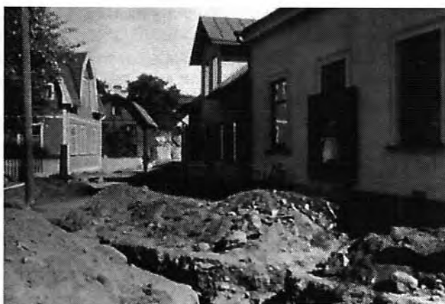
Schakt på L:a torget vid vattenledningsgrävningen 1925. Kv. S:ta Gertrud t.v. Kv. Urmakaren t.h. Foto i ATA (nr I).
