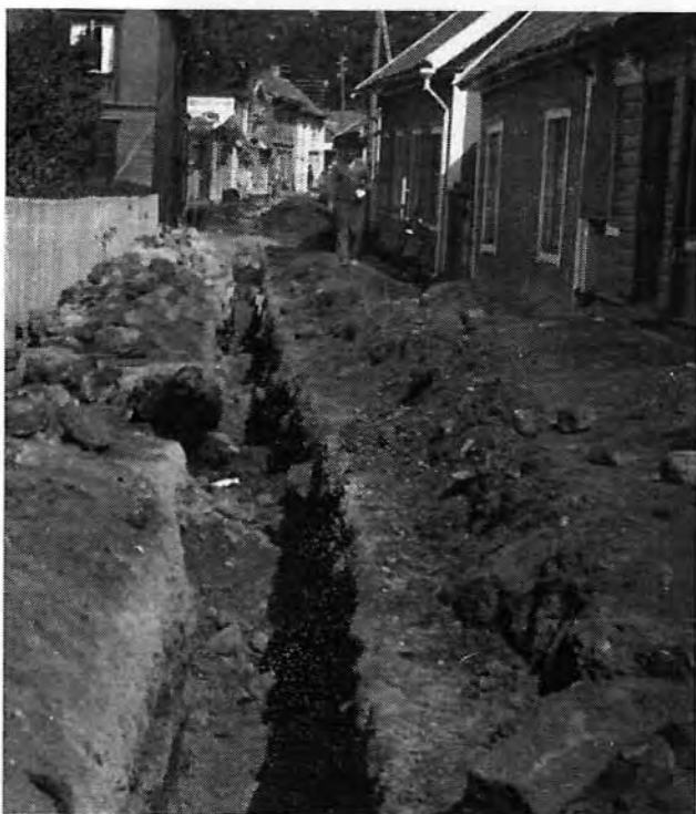
Schakt i Stora gatan vid vattenledningsgrävningen 1925. T.v. kv. Trädgårdsmästaren 9. Foto i Sigtuna Museums arkiv.
