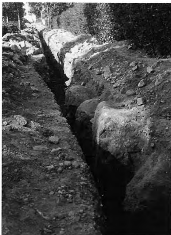
Schakt i Prästgatan vid vattenledningsgrävningen 1925. Foto i Sigtuna Museums arkiv.
