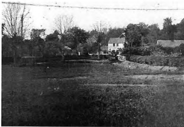
Schaktning runt kv. Trekanten vid vattenledningsgrävningen 1925. Foto i ATA (nr III) och Sigtuna Museums arkiv.
