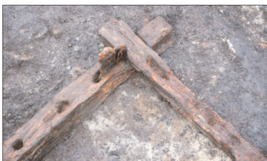
Figur 56. Den västra knuten i slätverksbuset 206 från öst. Träramen ligger direkt på marken utan underliggande stensyll. Notera hålen för slätverkskonstruktionen och de anslånga tapphålerna för det stående ramverket.
