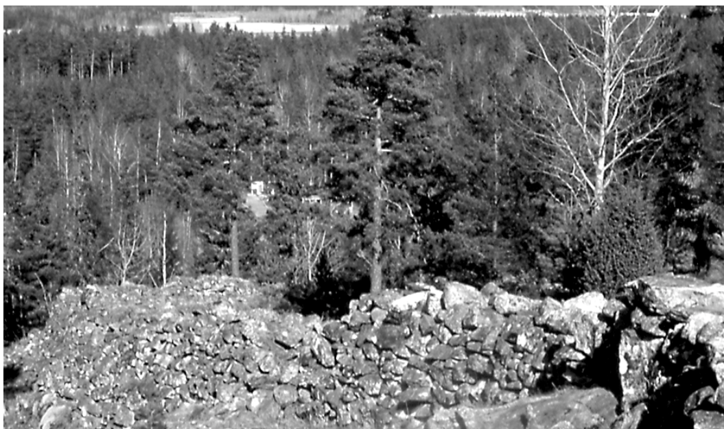
Fig. 2. Utsikt över Ogaklev i Ärla som med sina över två meter kvarstående yttre murliv är den bäst bevarade i Rekarnebygden. Foto Olle Lorin
