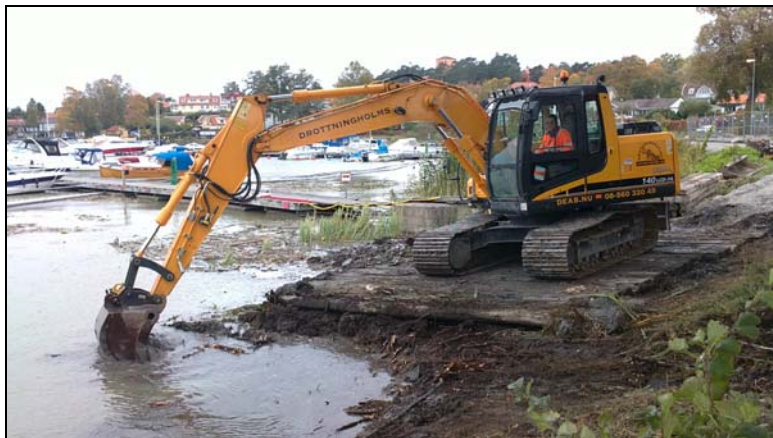
Fotografiet visar schaktningsarbetet i hamnen längs strandkanten. Bilden är tagen från öster.
