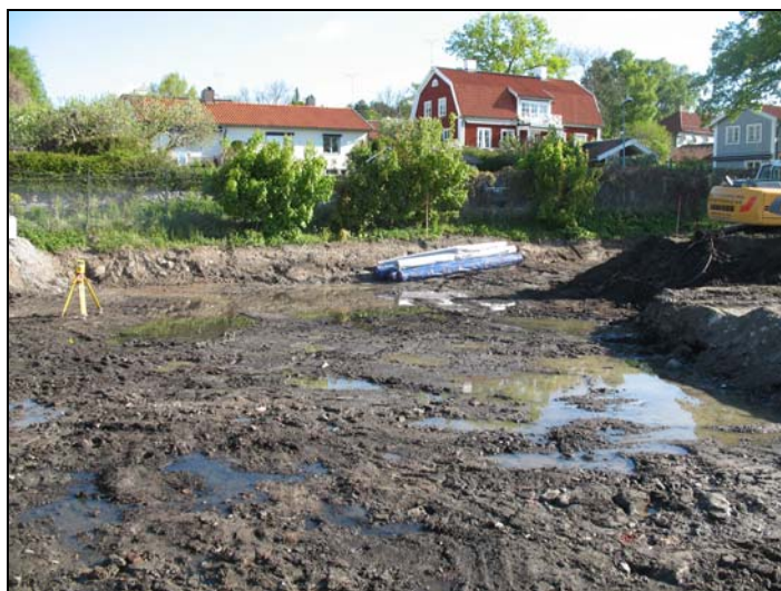
Fotografiet visar schaktningsarbetet vidd båtuppläggningsplatsen. Bilden är tagen från söder.
