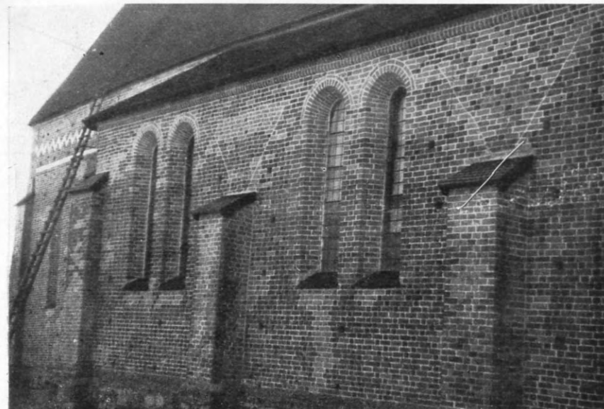
Fig. 5. Parti av nordfasaden.
