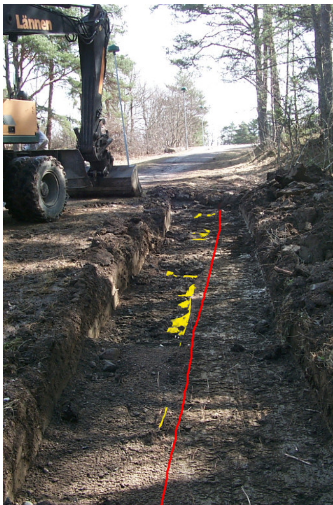
Figur 6 Schakt 5 från väster med starkströmskablar markerade med gult och gränsen för nedgrävningen i rött.
