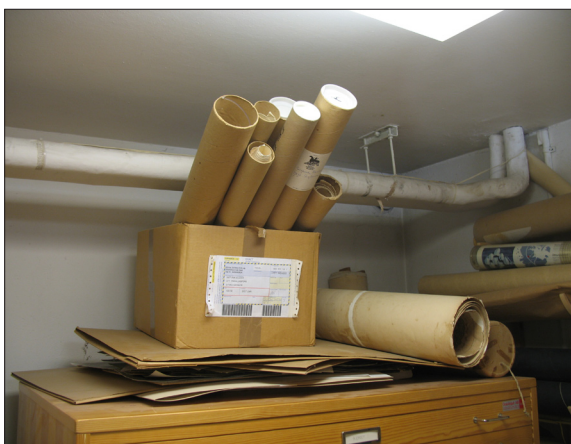
Fig. 8. Arkivmaterial utsatts för påfrestningar genom olämplig förvaring. Vattenledningar i taket
