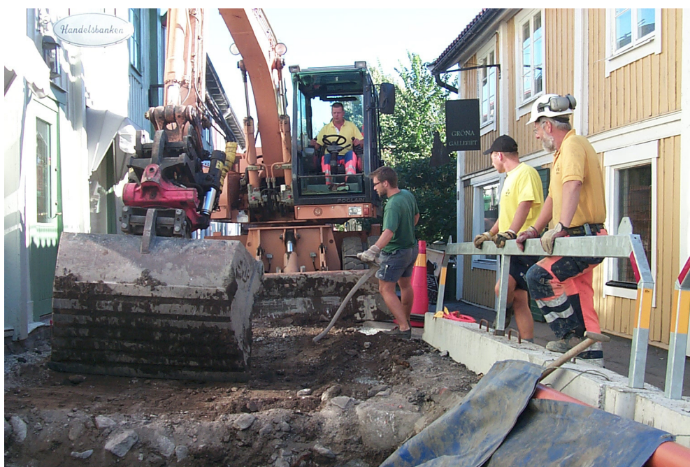
Figur 41 Schaktning med grävmaskin innan handgrävning tar vid.
