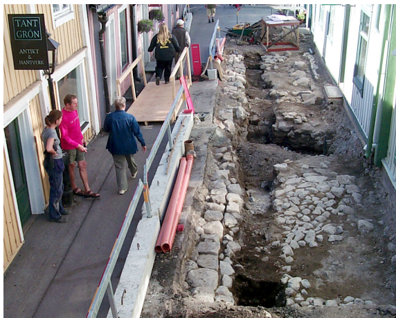
Figur 6 Bärlager av större stenar till en av gatorna från 1600- eller 1700-tal med en markant mittsträng i mitten av bilden.
