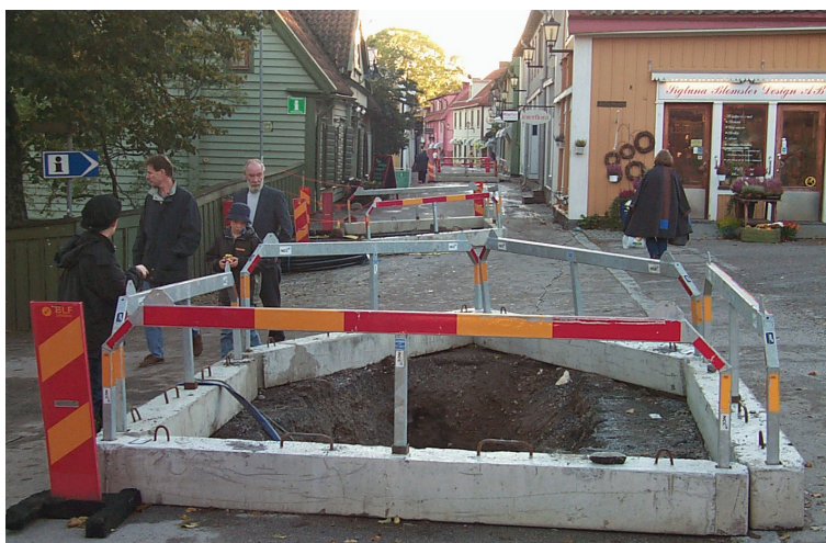
Schakt 1 vid Stora Torget, schakt 6 framför kv Draken och längst bort schakt 3 vid Laurentii gränd. Bilden tagen mot väster.
