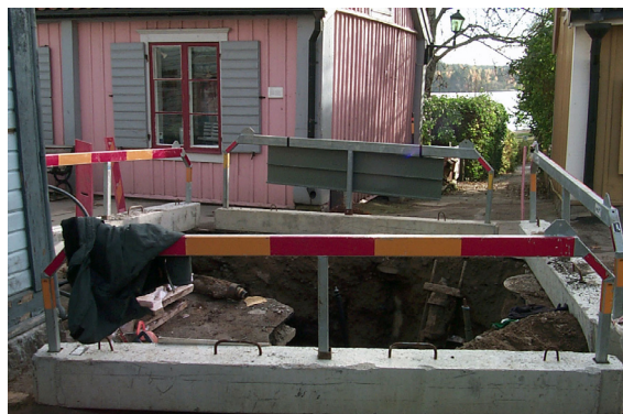
Schakt 5 i korsningen Stora Gatan - Laurenti gränd. Bilden tagen mot söder.
