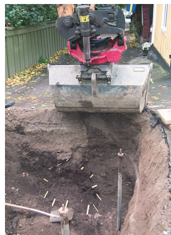
Schakt 3, foto mot söder
