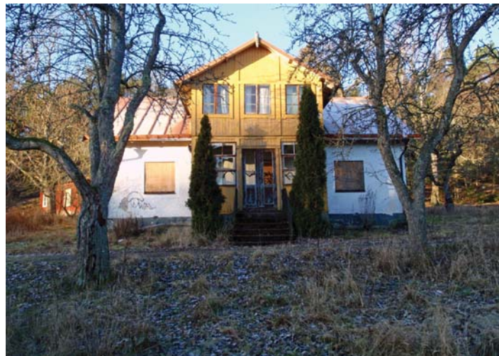
Fotografi över huvudbyggnaden. Bilden tagen från öster.
