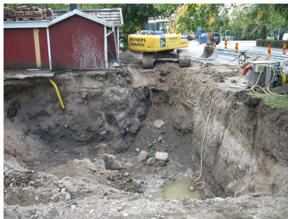
Uppgrävt schakt som det såg ut vid den antikvariska kontrollen.
