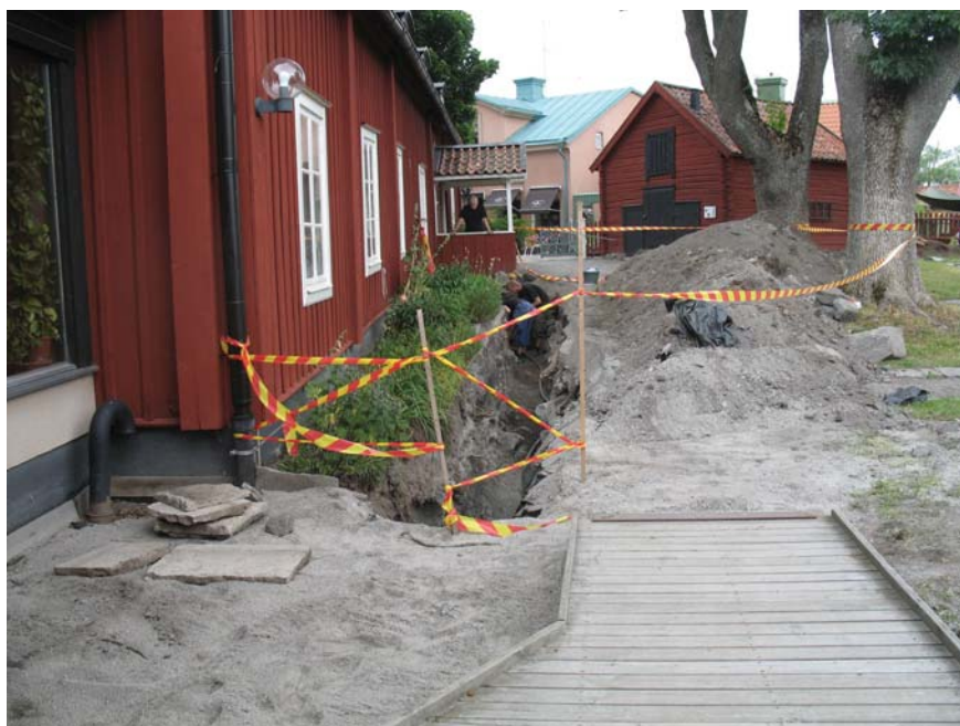
Översiktsbild på schaktet. Bilden tagen från väster vid museets entré.
