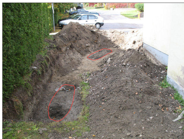
Bild över Grav 1 och 2 i schakt 3 innan utvidgningen. Bild tagen från öster.
