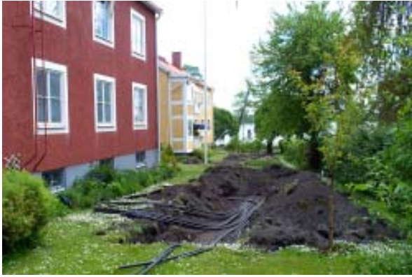
Schaktet för bergvärmeledningarna, från norr.
