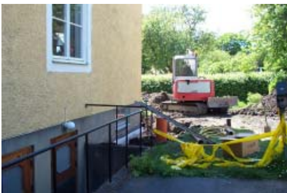
Dräneringsschaktet i det nordvästra hörnet av den södra fastigheten
