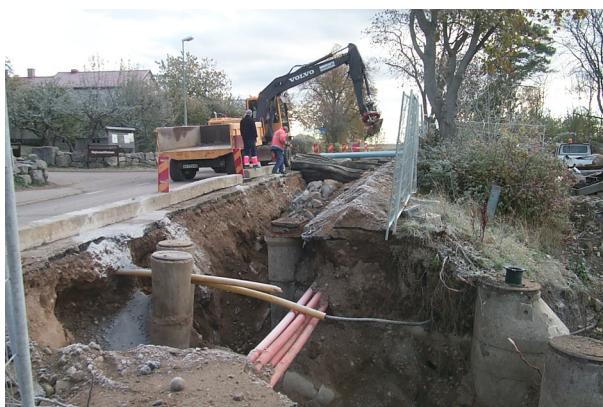
Schakt 2 fotograferat från väster. Till vänster i bilden syns infarten till Sigtunastiftelsen och ungefär vid grävmaskinens arm påträffades gravarna.
