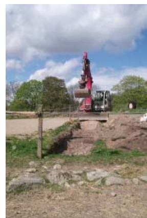
Schaktning med grävmaskin
