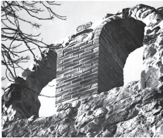
Figur 50. S:t Lars delvis rekonstruerade fönsteröppningar i tegel, mot väster. Foto efter restaureringen 1970 (ATA 7544/70).
