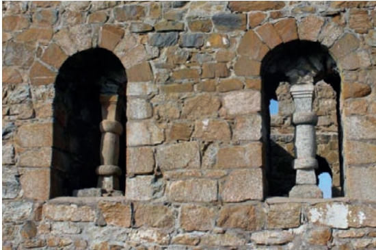
Figur 14a och 14b. Mittposter i fönsteröppningarna i centraltornet (efter Thelin, Balksten & Löfberg 2017-09-15)
