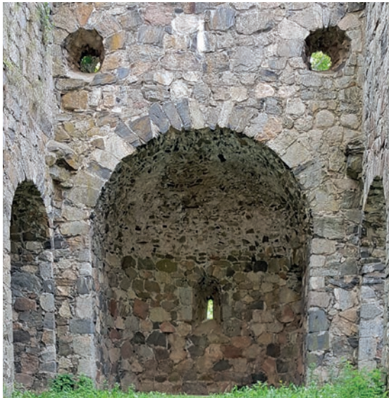
Figur 38. Runda fönsteröppningar i koret östra vägg, mot öster.
