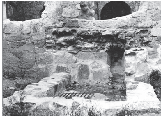
Figur 69. Brunnshuset uppmurat (ATA). Foto Sörling 1890-tal.
