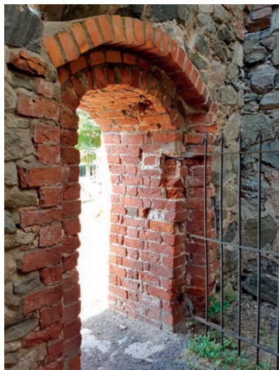
Figur 33. Portal i södra korsarmen, byggd i tegel, mot söder.
