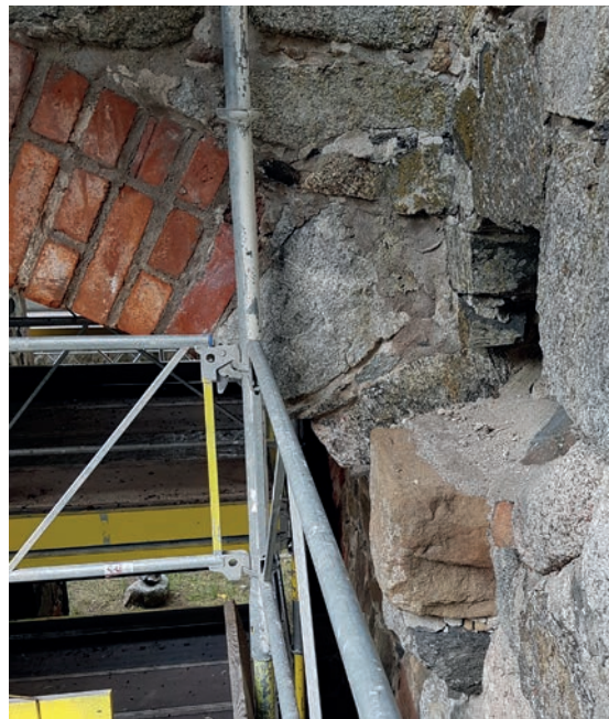
Figur 29. Kragstenar i koret nere till höger i bild. Mot väster.
