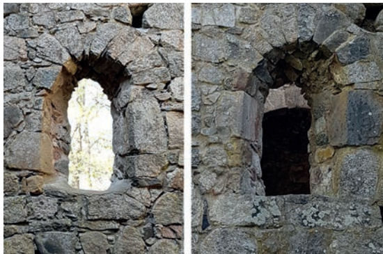
Figur 15. Fönsteröppning i norra korsarmen (inifrån vänsterbild, utifrån högerbild).
