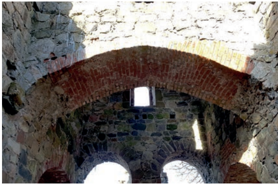
Figur 27. Valvbåge i centraltornet med ursprungliga stenbågen in mot hörnen som har en snävare spännvidd än tegelstensbågen. Mot öster.
