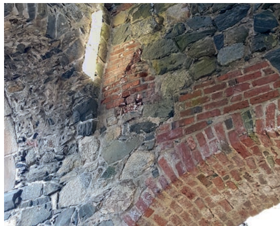
Figur 30. Igenmurad kragsten/upplag/valvpelare i centraltornet, mot nordväst.
