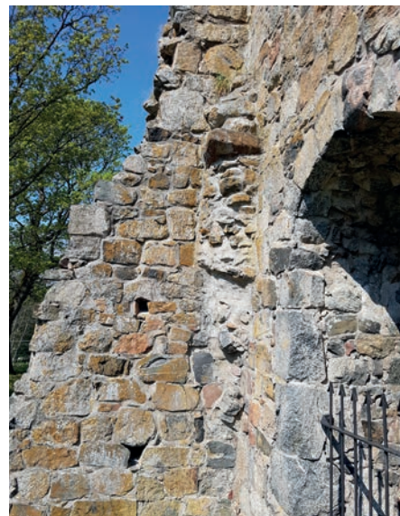
Figur 19. Möjliga rester efter en valvpelare i den södra korsarmen.
