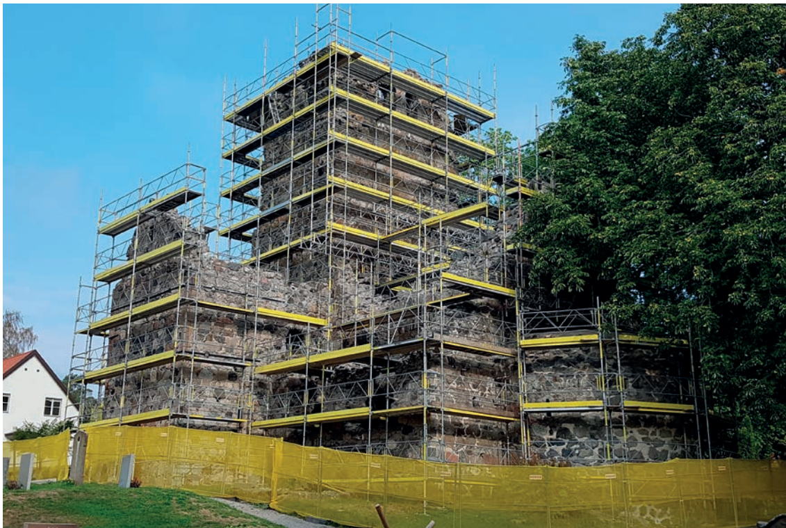
Figur 73. Restaureringsarbeten på S:t Olof 2018.
