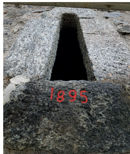
Figur 36. Den södra fönsteröppningen i koret med året 1895 inristat. Årtalet är digitalt ifyllt med rött för att förstärka inristningen. Mot norr.
