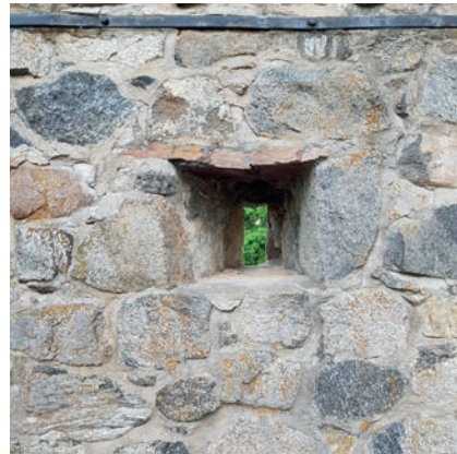
Figur 17. Fönsteröppning i andra våningen på västtornet.
