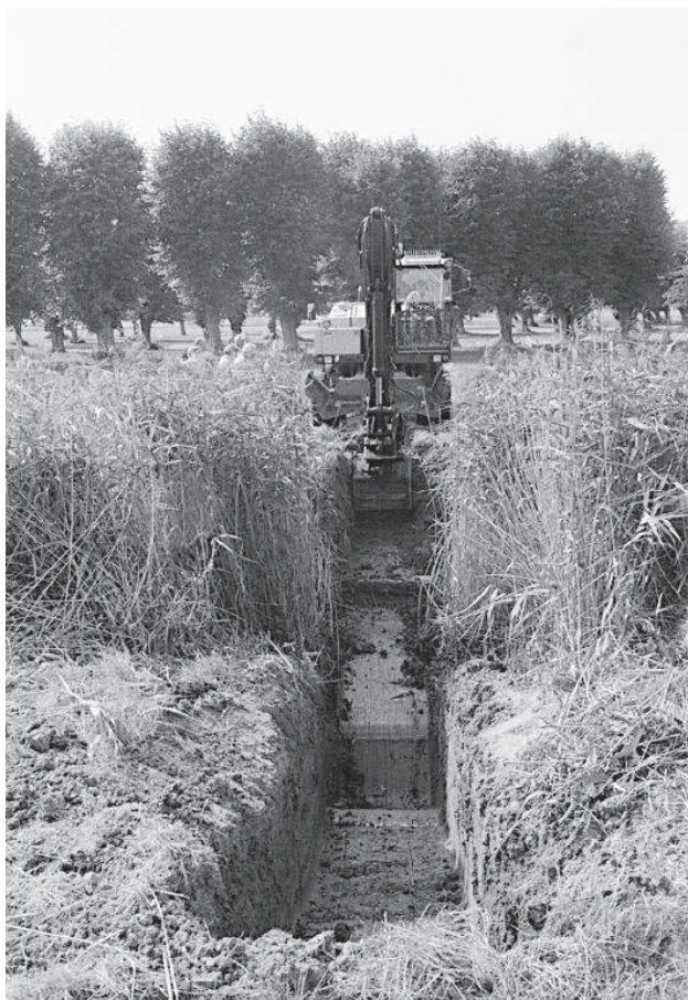
Figur 10. Schakt D–D. Foto: Sten Tesch.
