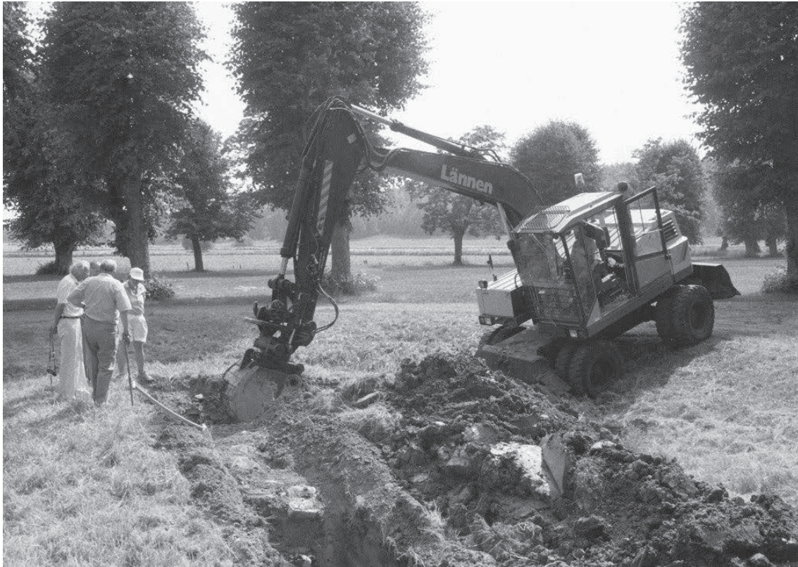
Figur 15. Schakt A-A. Foto: Sten Tesch.
