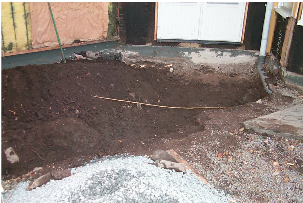
Fig. 2, schaktbild tagen från sydväst som visar schaktets läge intill södra sidan av byggnaden på fastigheten Lergöken 1.
