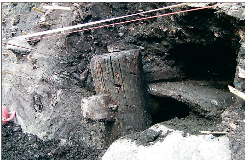
Figur 49. En del av brokonstruktionen grupp 76 framrensad ur profilen, med stolpe och och ett litet stycke ur broläggningen synlig längst till höger.
