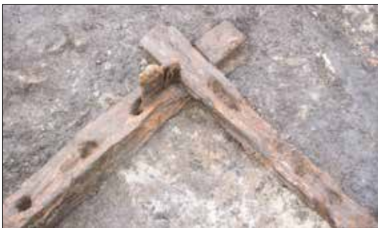
Figur 56. Den västra knuten i flätverksbuset 206 från öst. Träramen ligger direkt på marken utan underliggande stensyll. Notera hålen för flätverkskonstruktionen och de anlånga tapphålen för det stående ramverket.
